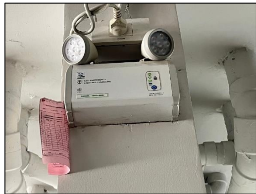
รูปที่ 22 ระบบสำรองไฟในโครงการ
