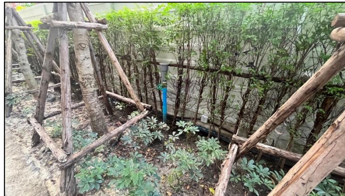
รูปที่ 18 ท่อระบายอากาศของบ่อบำบัดก๊าซมีเทน
