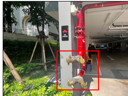
รูปที่ 25 ระบบท่อยืน (Stand Pipe) หัวรับน้ำดับเพลิงภายนอกอาคาร (Fire Department Connector : FDC)
