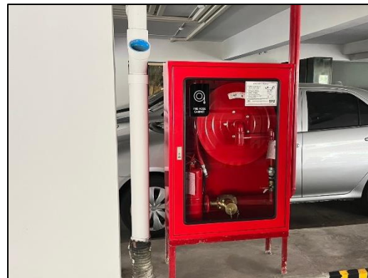
รูปที่ 26 ตู้เก็บสายฉีดน้ำดับเพลิงพร้อมอุปกรณ์ (Fire Hose Cabinet : FHC)
